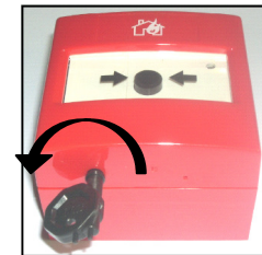
Figura 12 - reset meccanico del punto di chiamata
